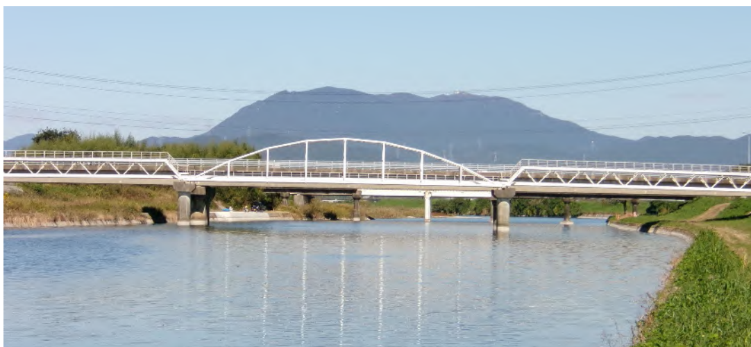
写真 5.2.1 大板井橋水管橋
